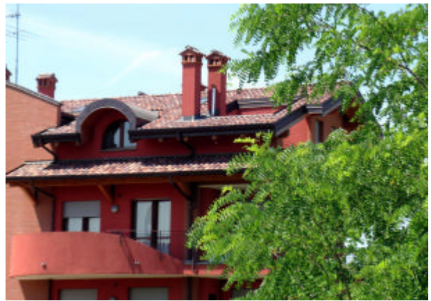
Foto 4 - Vista esterna (ultimo piano)
